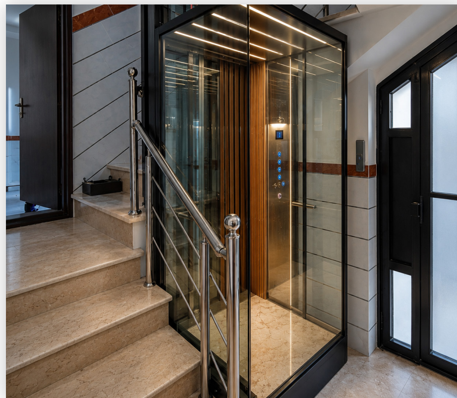
نمونه کار هوم لیفت کابین شیشه ای
